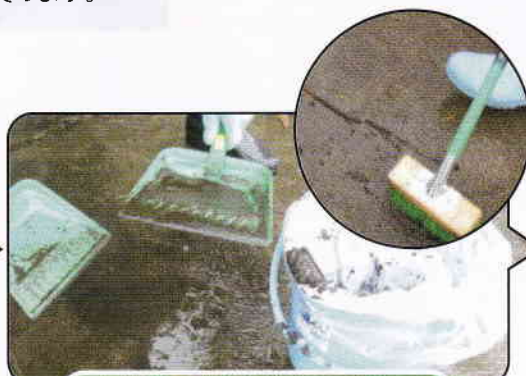
土砂等の除去（外側から内側へ）
