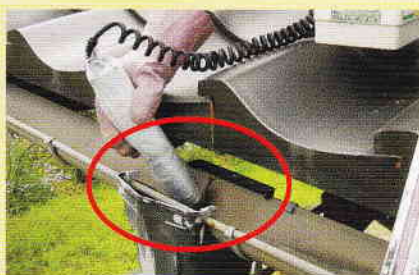
雨樋の集水器
