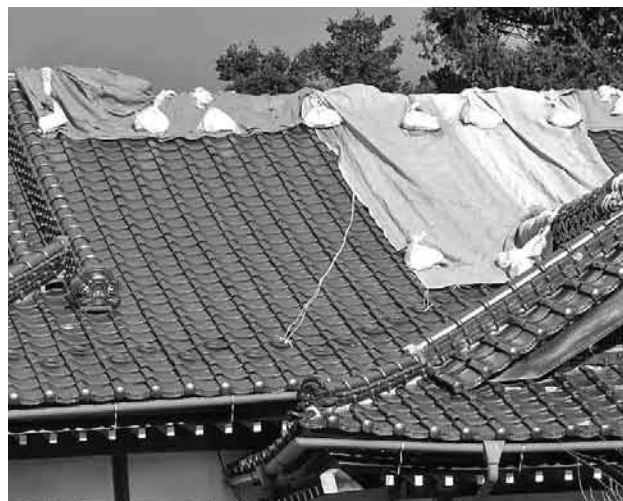
屋根瓦補修工事が完了していない民家
