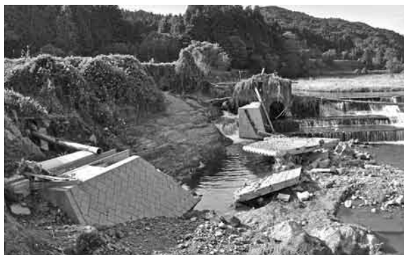
台風により被害を受けた孫目堰
