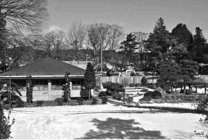
解体工事が進められている棚倉町中央公民館
