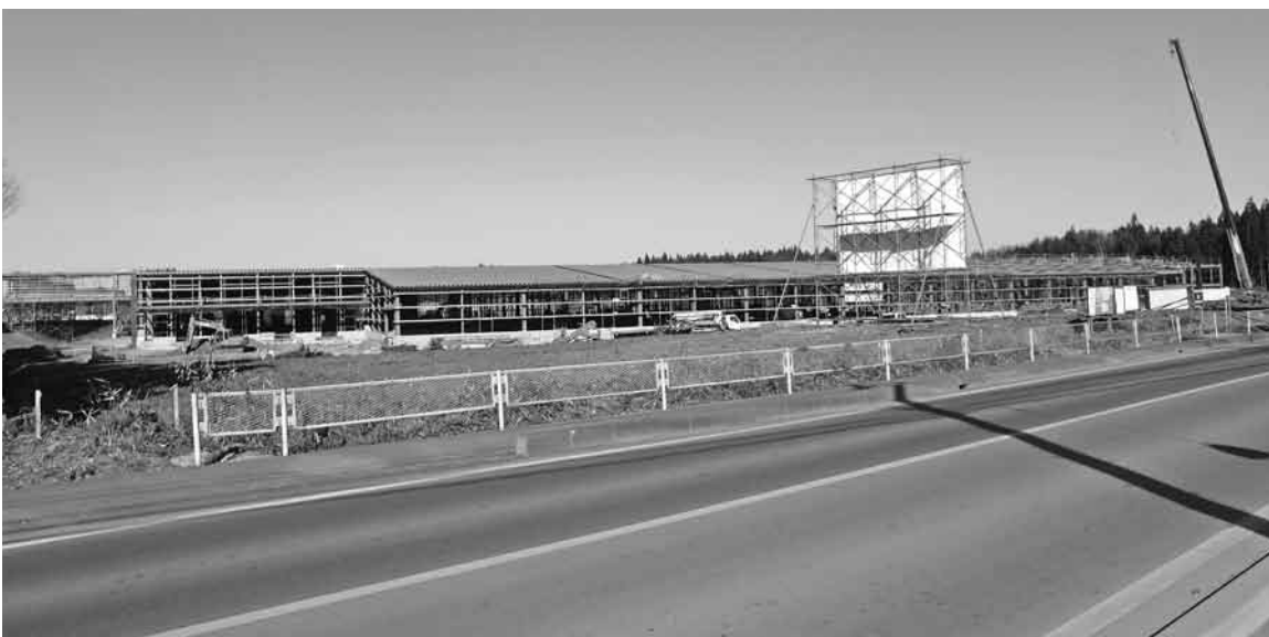
天王内地区に建設が進む進出企業倉庫
