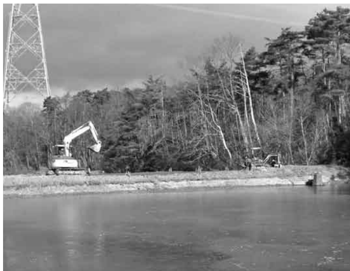
災害復旧工事中のため池(板橋区内)
