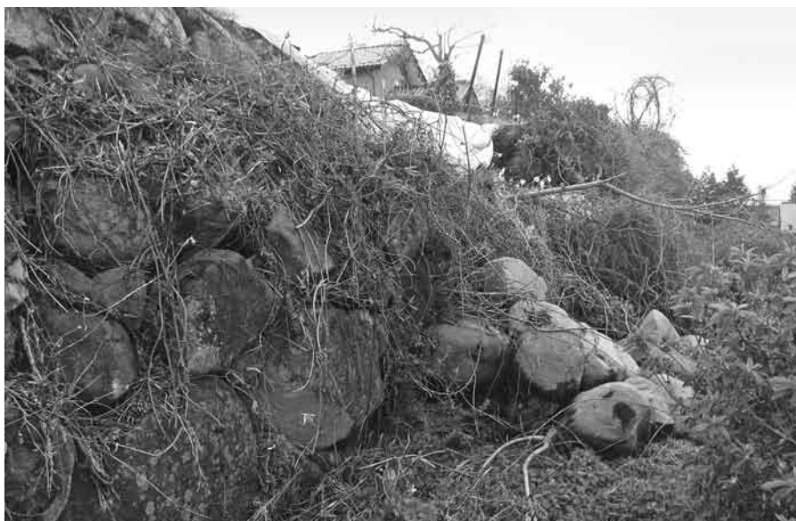
崩落した城跡西側の石垣
