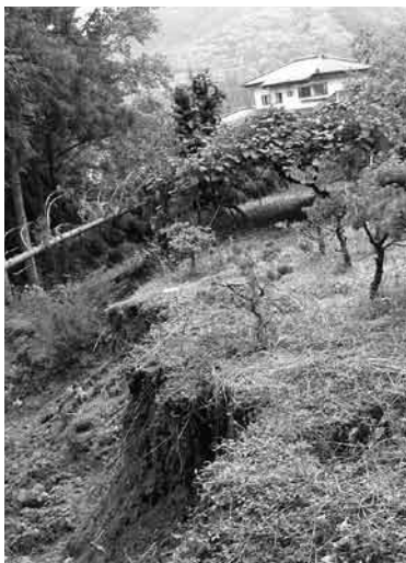
民家の裏で発生したがけ崩れ
