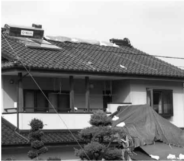
屋根の一部が損壊した民家
