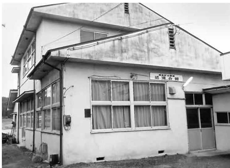
老朽化している近津分館
