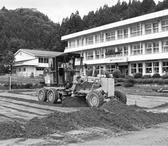
高野小学校での表土除去
