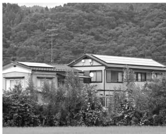
補助事業を活用して設置したソーラーパネル
