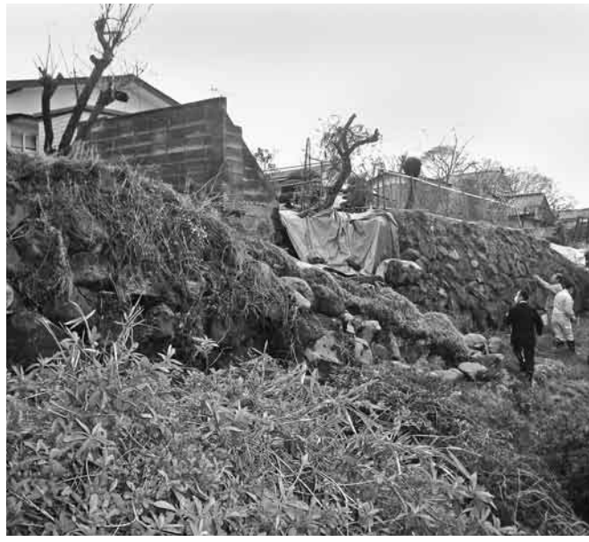
測量調査を行う棚倉城跡の石垣
