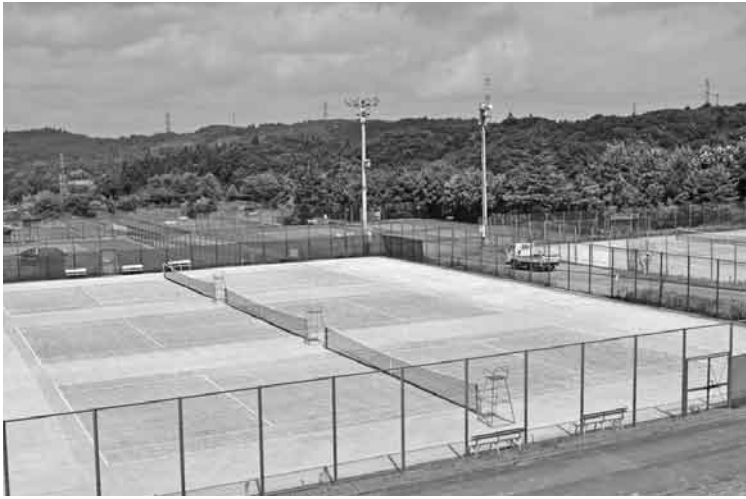
完成したルネサンス棚倉のテニスコート
