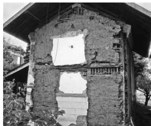
壁が落下した土蔵
