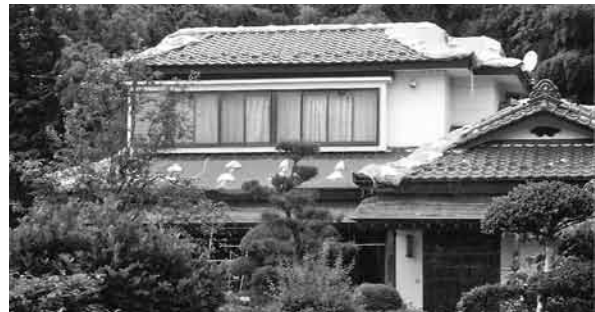
屋根瓦が被災した民家
