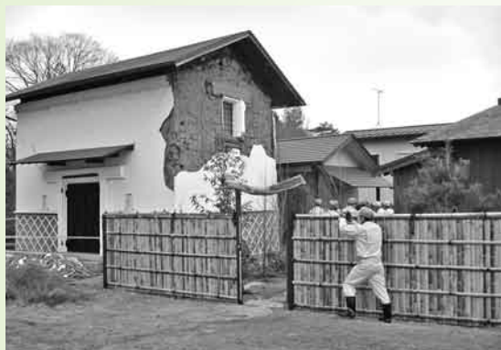
漆喰壁が落下した土蔵
