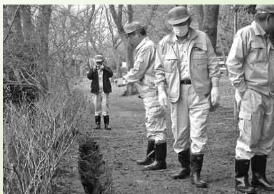
赤館公園の地割れ
