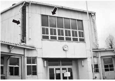
外壁や窓ガラスが破損した棚倉幼稚園
