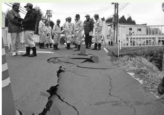
亀裂・陥没した天王内地内の町道
