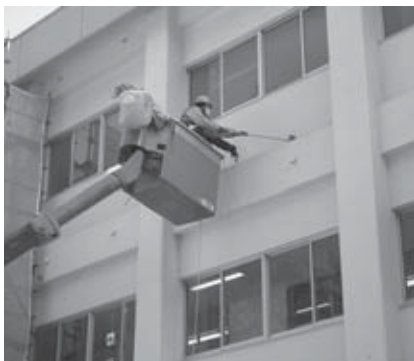
除染作業が開始された高野小学校
