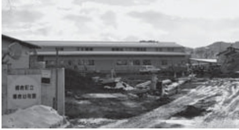
完成間近の棚倉幼稚園
