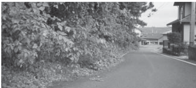
町道に草木が繁茂する法面(日向前ニュータウン地内)
