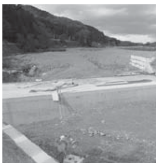
復旧工事が進む寺山堰
