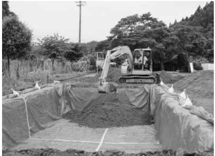
高野小学校校庭の表土除去作業
