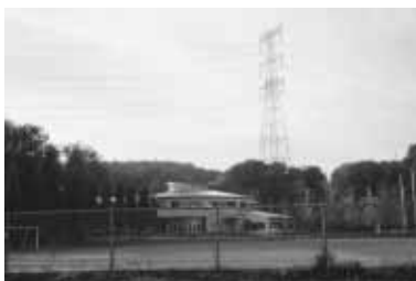
100万ボルトの送電線
