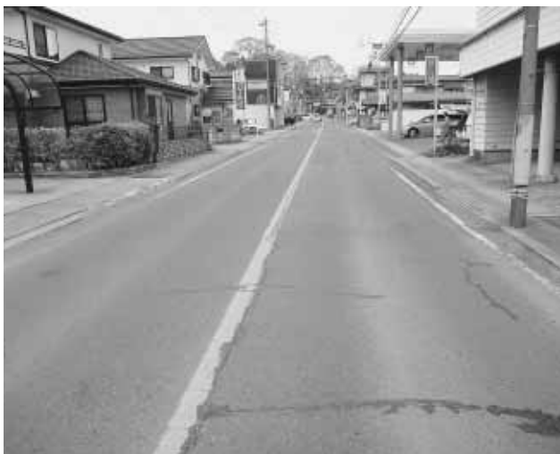
路盤改良工事が実施される磐城棚倉近津線
