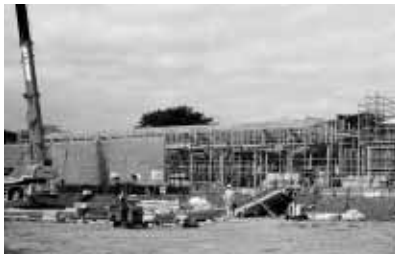
建築中の棚倉幼稚園
