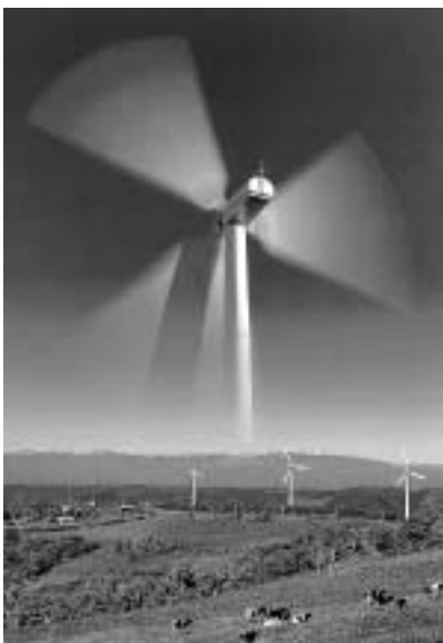
クリーンエネルギーの町葛巻町
