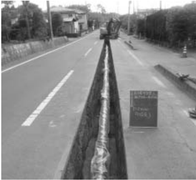
上台地区本管布設替工事
