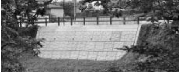
復旧の完了した城跡堀の法面
