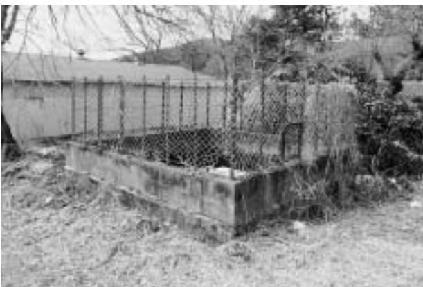
改築が予定される福岡地区防火水槽
