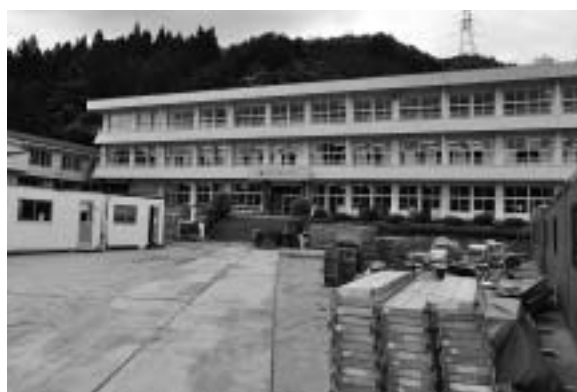
高野小・幼稚園耐震工事
