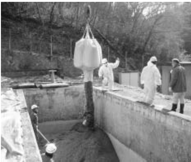
昨年度実施した山岡簡易水道施設濾過池の濾過砂入替作業
