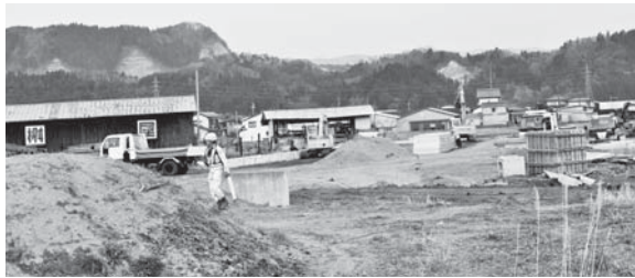
造成中のJA直売所
