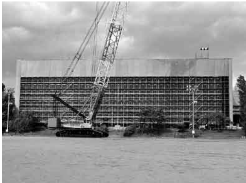
改修工事中の総合体育館
