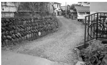
舗装化の要望がある町道宮下1号線
