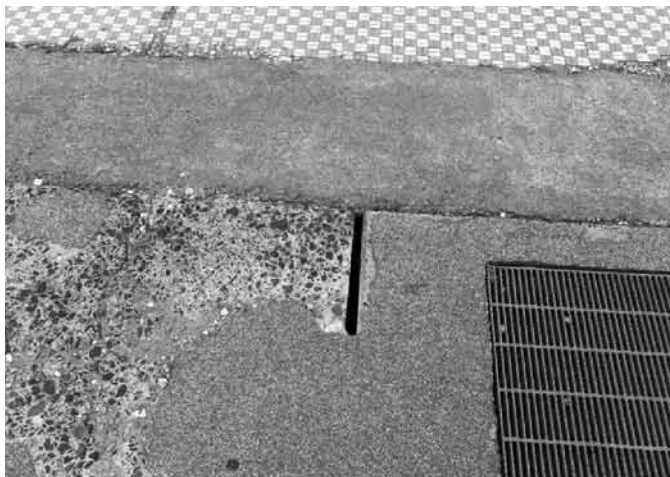
劣化の目立つカラー歩道
