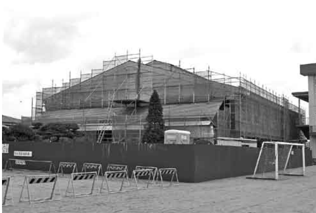
近津小学校屋内運動場
