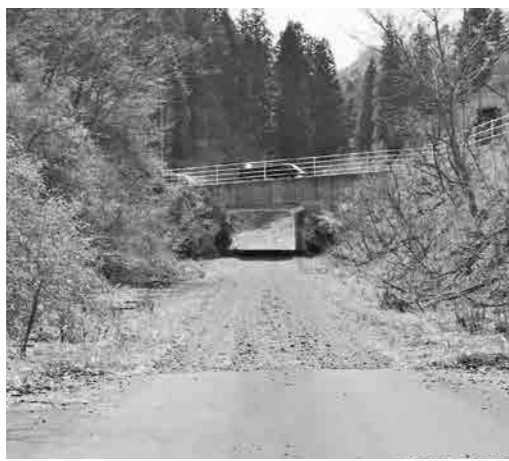
桜木地区 通称赤道未舗装部分
