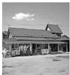
改築が待たれる棚倉第一保育園舎
