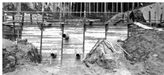
流地区(豊都)治山工事現場
