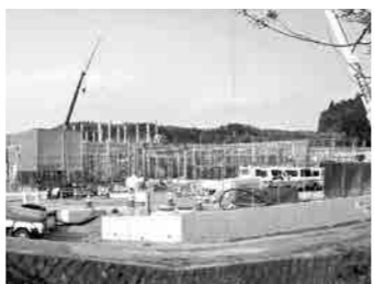
建設中のほたるの里
