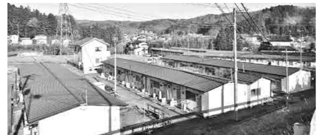
町営住宅小山下北・南団地
