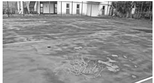
20年経過したルネサンス棚倉のテニスコート
