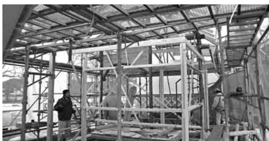
移築復元工事中の茶室
