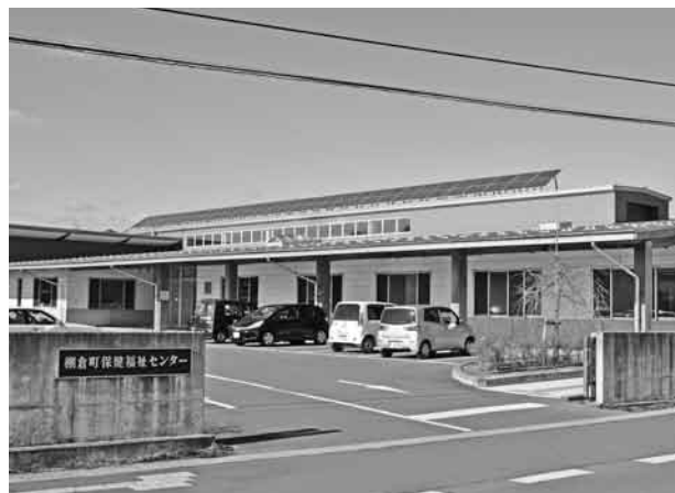
太陽光発電パネルが設置されている保健福祉センター
