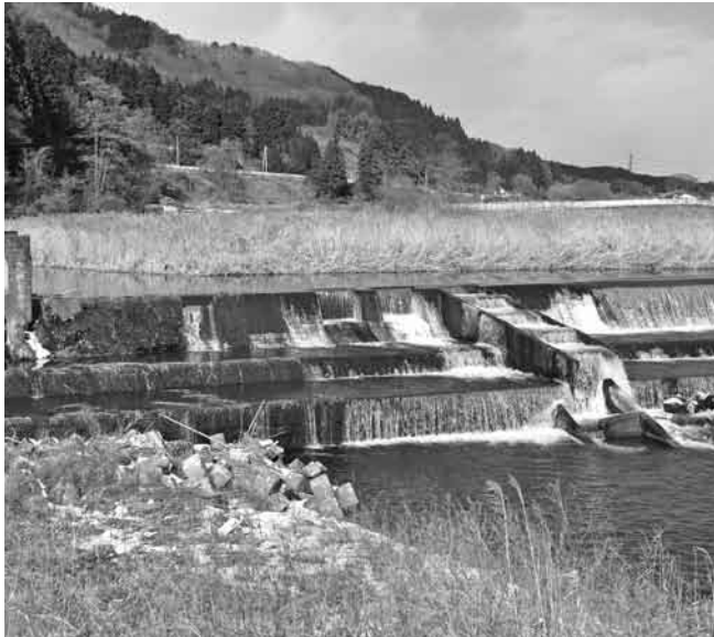
老朽化が進む孫目堰
