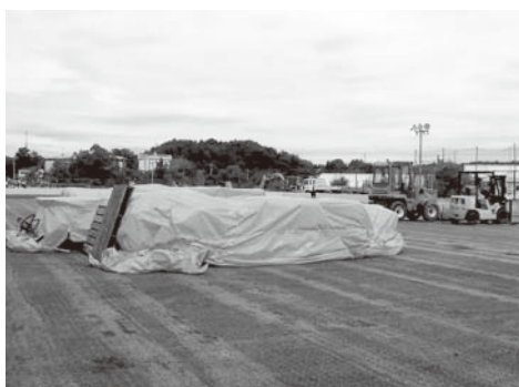
▶ルネサンス棚倉多目的広場整備工事
