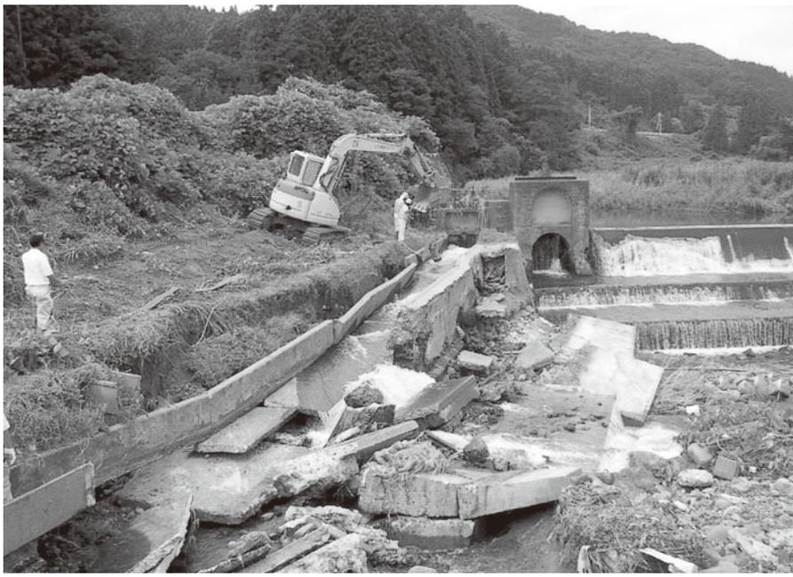
▲崩落した孫目堰用水路
