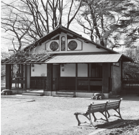
▲破壊防止対策を検討する亀ヶ城公園公衆トイレ
