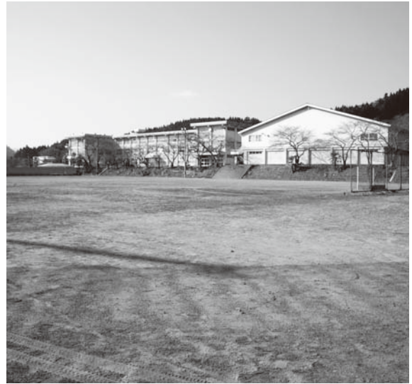
▲有効利用が期待される旧棚倉高校跡地
