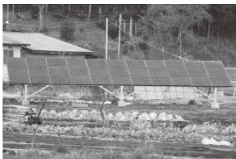
▲民家の敷地に設置された太陽光発電
