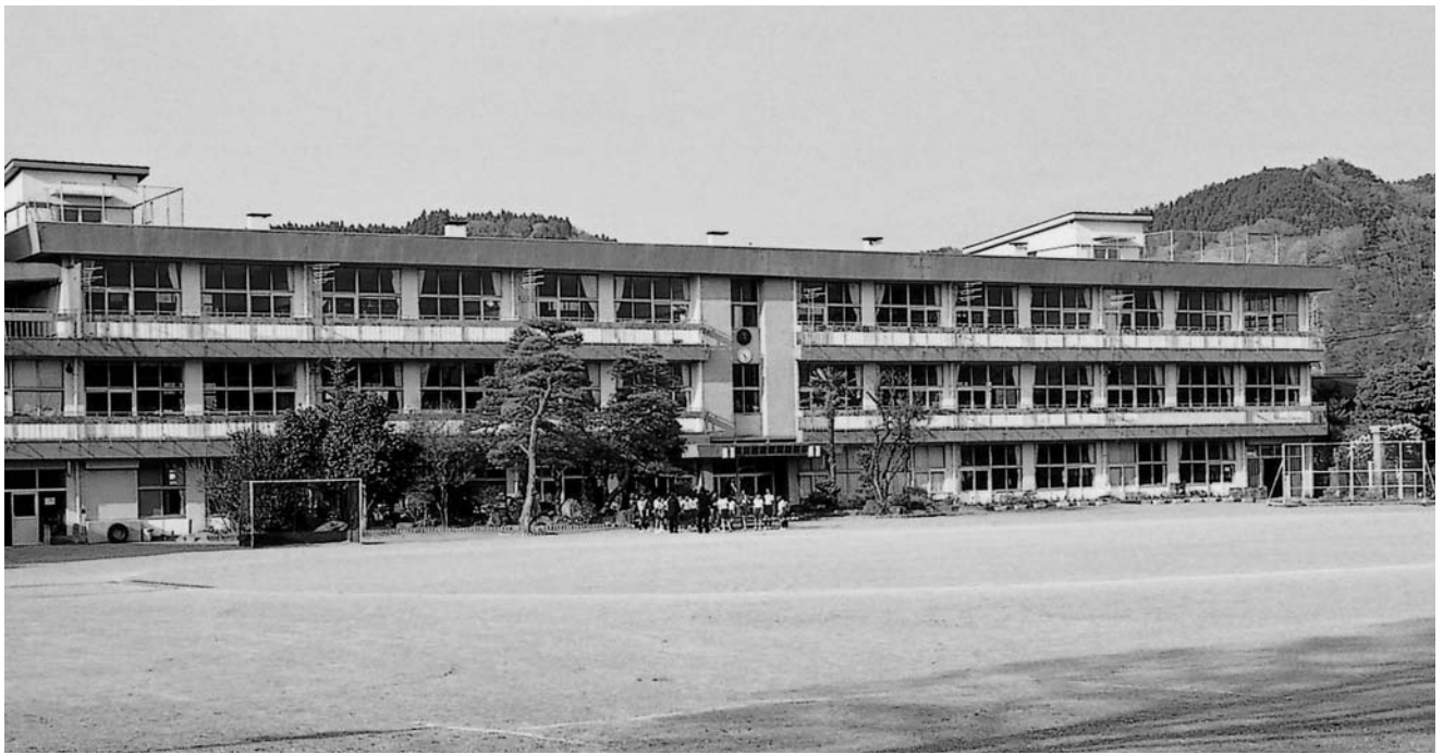
▲耐震補強改修工事が予定されている近津小学校舎
