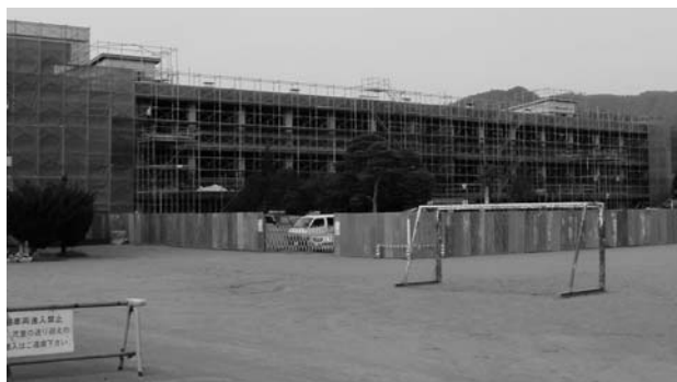
▶耐震補強改修工事が行われている近津小学校
