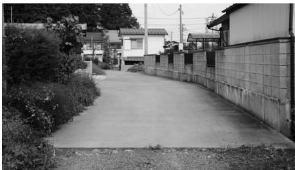
▶原材料支給によるコンクリート舗装（町道風呂ヶ沢松木線）
