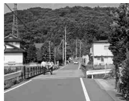
拡幅が望まれる豊川橋
