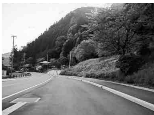
歩道整備中の富岡地区
