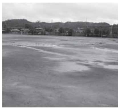
改修が望まれる柵倉運動広場
