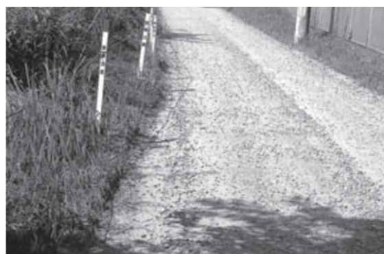
今年度中に舗装化される田楽橋周辺の町道
