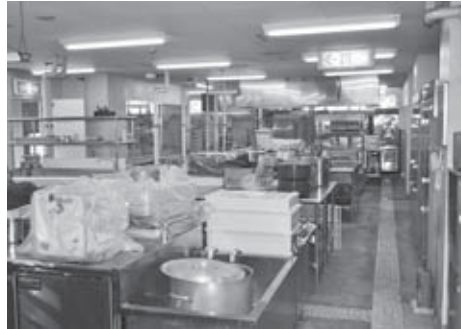
改修が予定されているルネサンス棚倉パルテノン厨房
