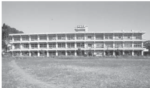
今後、取り壊しが計画されている旧棚倉校舎
