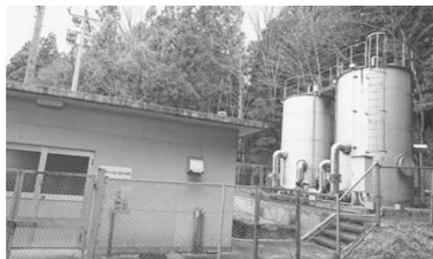
廃止計画されている堤地区の第5取水場
