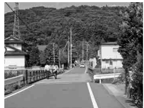
拡幅が望まれる豊川橋
