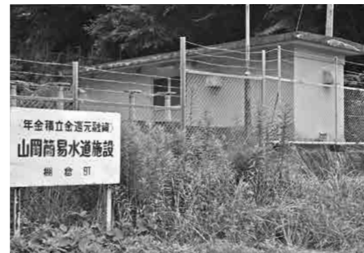
山岡簡易水道施設
