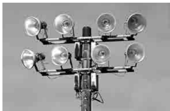
老朽化している夜間照明
