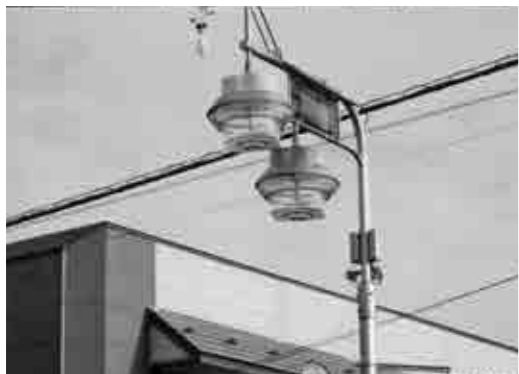
老朽化している街路灯
