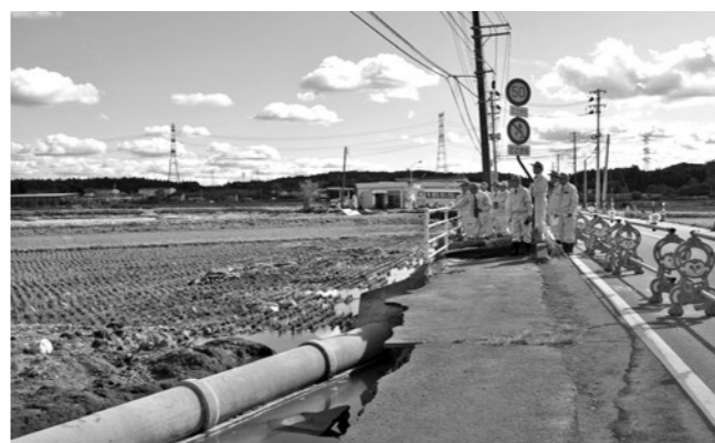
社川地区 県道棚倉・矢吹線法面崩落（堤字塚田内地内）
