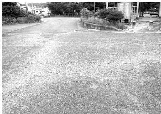
劣化による傷みの目立つカラー舗装
