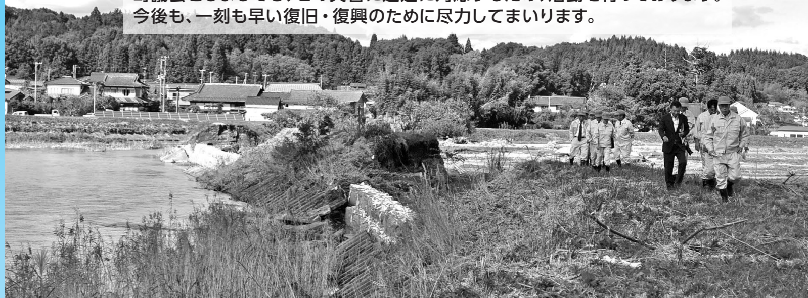
社川地区 社川堤防決壊（一色字太夫内地内）
