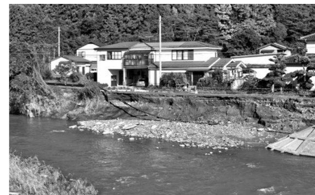
近津地区 久慈川護岸崩落（寺山字豊岡内地内）
