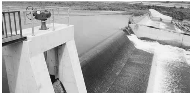
災害復旧工事が完了した寺山堰
