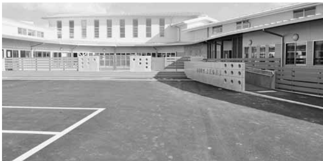
改築工事が完了した棚倉幼稚園
