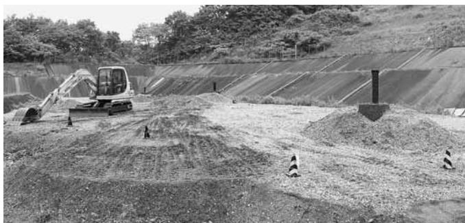
塙町にある最終処分場。汚水浸出検知システムや高密度ポリエチレンシート・熱融着ゴムシートなどにより安全かつ厳重に埋立が行なわれている。
