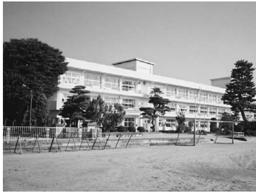
▲耐震補強改修を終えた棚倉小学校南校舎
