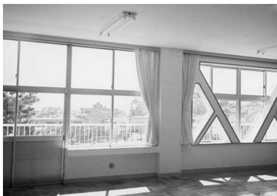
▲耐震補強改修を終えた棚小南校舎の教室
