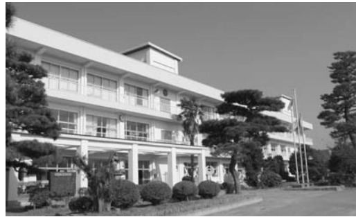
▲工事終了後の南校舎
