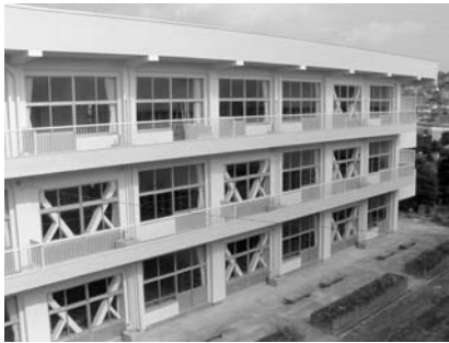
▲工事終了後の北校舎
