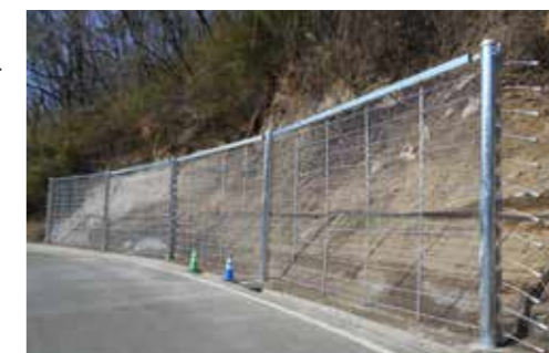
落石防護柵を設置した町道岡田西河内線
