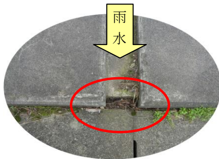
雨樋からの排水先
