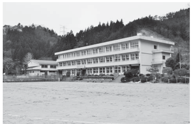
耐震工事が行われる高野小学校舎と屋内運動場
