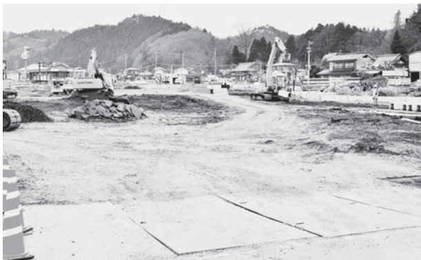
造成中のJA直売所
