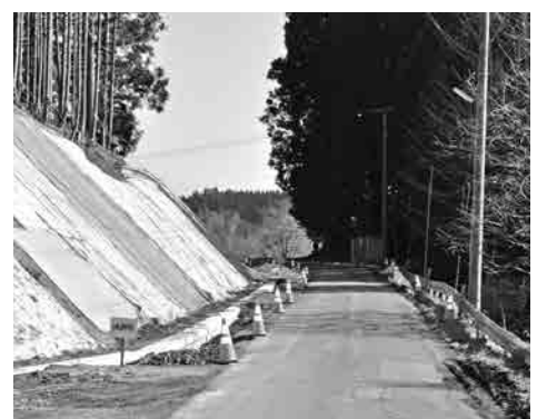
段河内平塩線(中山本字山口地内)
