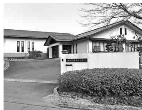
公共下水道を処理する棚倉町浄化センター
