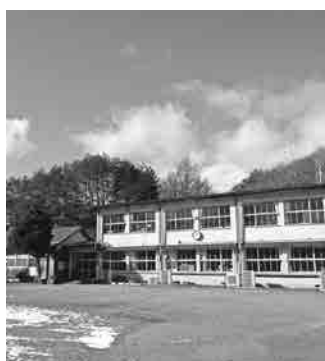
耐震補強工事を行う山岡小学校
