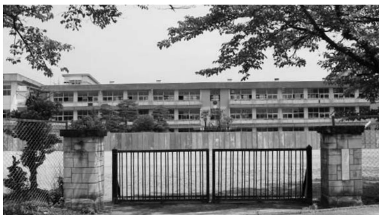
▲入札が行われた近津小学校耐震改修工事
