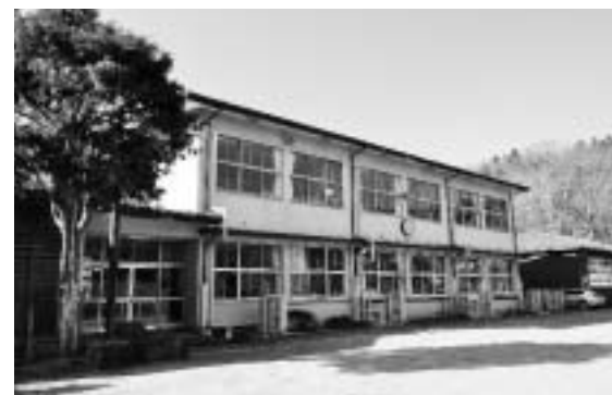
耐震補強工事を行う山岡小学校
