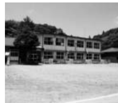
耐震補強工事を行う山岡小学校
