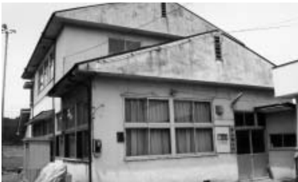
老朽化の進む寺山集会所
