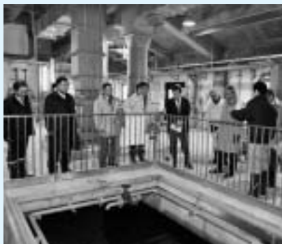
処理施設内部の様子
