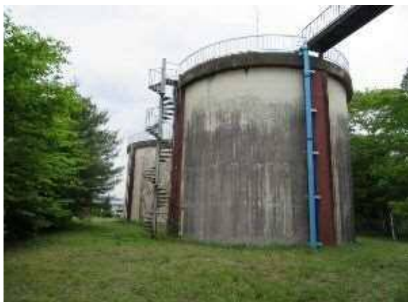
「八幡沢第2配水池」
