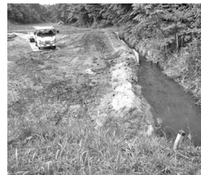
復旧に向けて進む小規模工事
