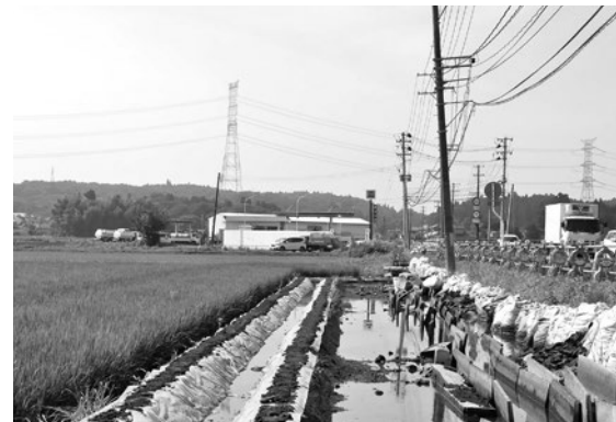
復旧が進んでいる県道棚倉・矢吹線／社川地区(堤字塚田地内)
