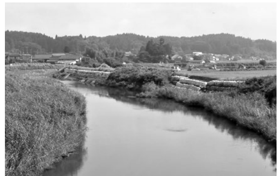
復旧が進んでいる社川堤防／社川地区(一色字太夫内地内)
