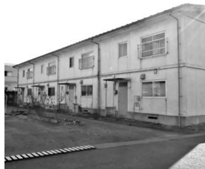
改修予定の南町東団地
