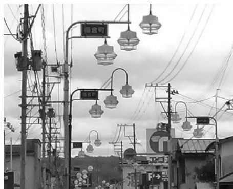
老朽化が進む街路灯
