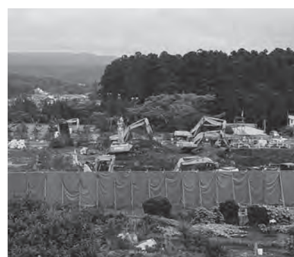
解体終了が迫る旧棚倉高校跡地
