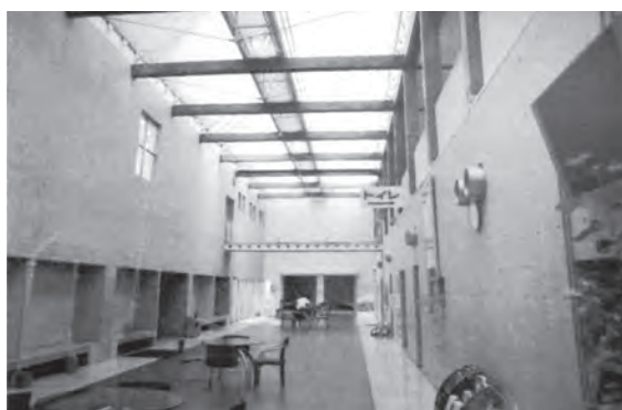
劣化が目立つガレリア（館内）
