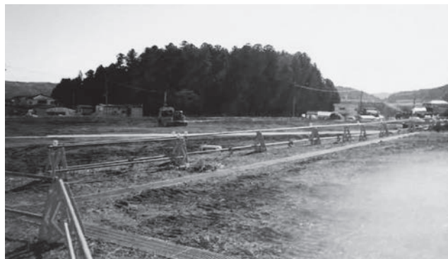
解体工事が終わった棚高跡地
