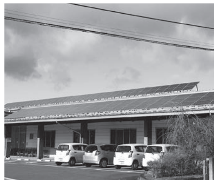
保健福祉センターに設置の太陽光システム
