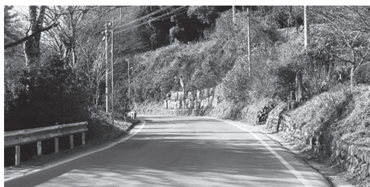
道幅が狭くカーブが多い薬師堂—高瀬区間
