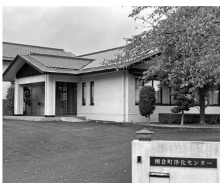
棚倉町浄化センター
