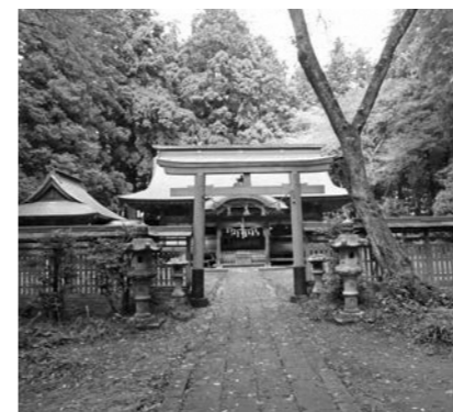
国指定重要文化財の本殿がある神社
