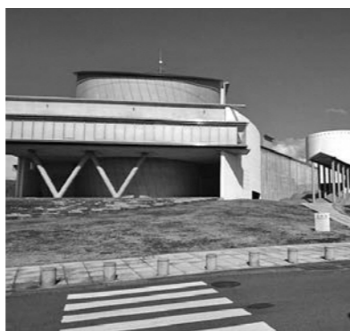
改修が予定される棚倉町文化センター
