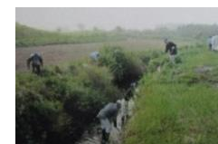
棚倉堀の清掃作業
