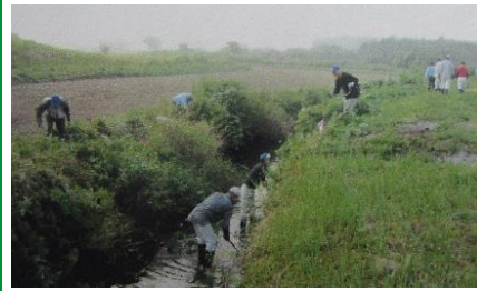
棚倉堀の清掃作業
