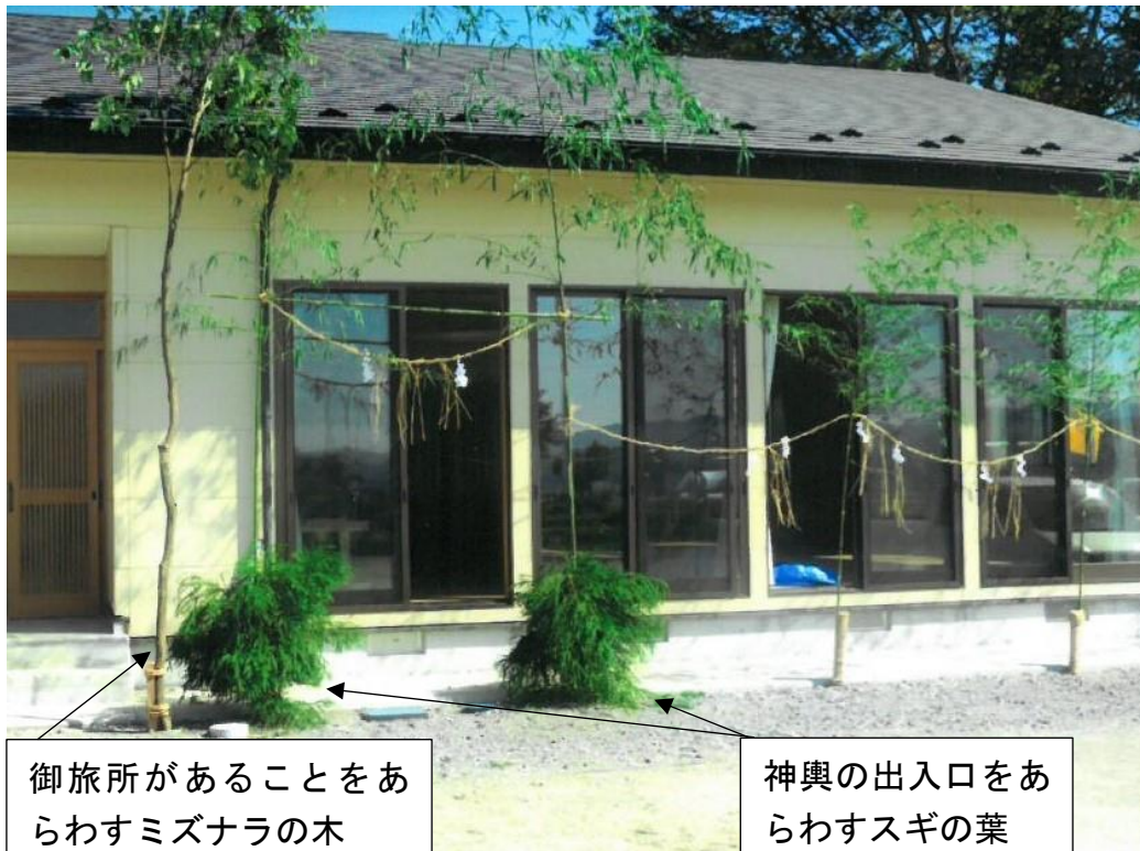
御旅所が設置される堤区コミュニティセンター
