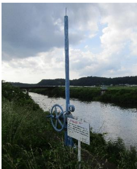
現在の棚倉堀水門
