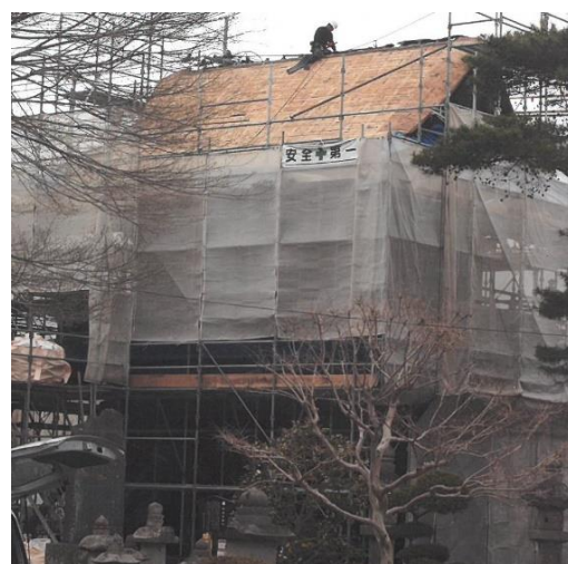
蓮家寺山門修理
