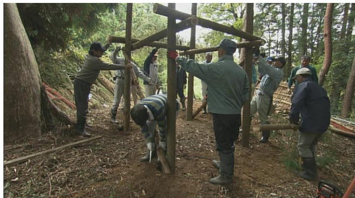
御仮屋造営の様子
