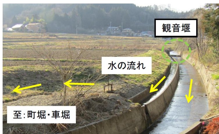
町堀・車堀に取水している現在の観音堰
